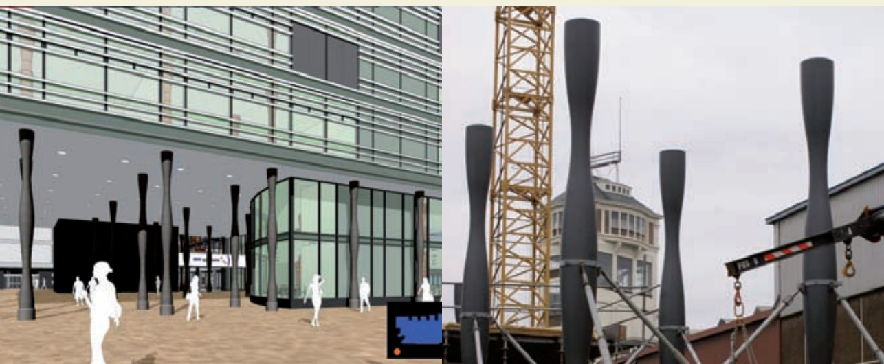
Gietijzeren kolommen - ROC Twente
